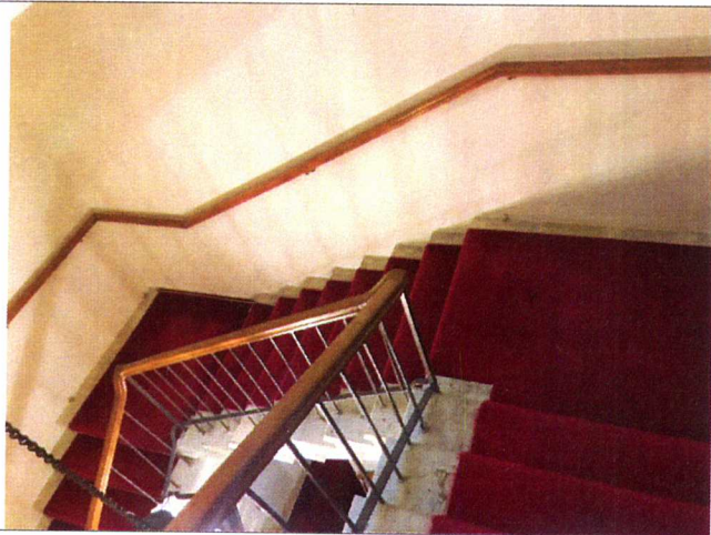
Фото №17 – Пути движения внутри здания (лестницы)
