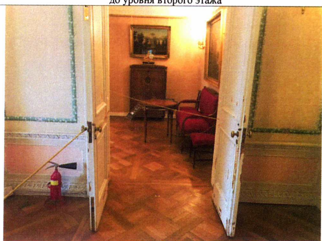
Фото №24 – Пути движения внутри здания (двери)
