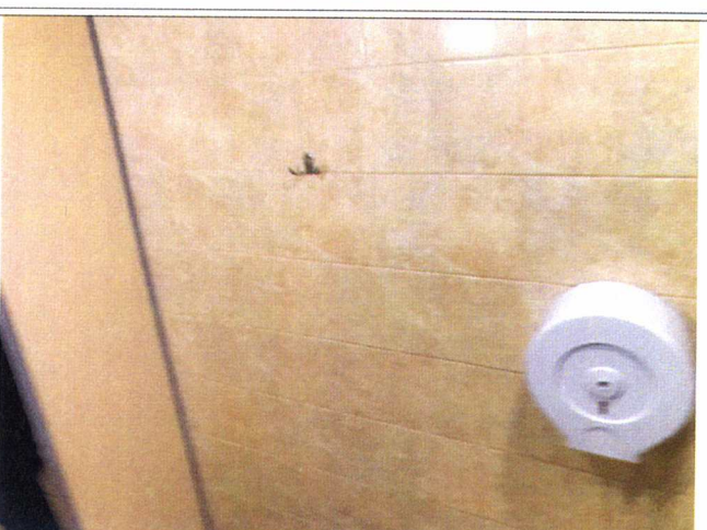
Фото №48 – Санитарно-гигиенические помещения
