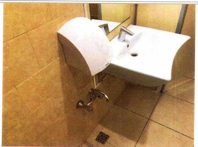
Фото №47 – Санитарно-гигиенические помещения
