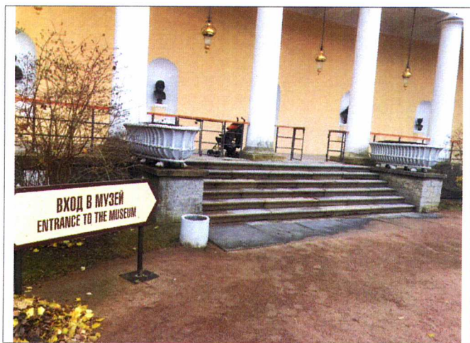
Фото №7 – Главный вход. Наружная лестница главного входа
