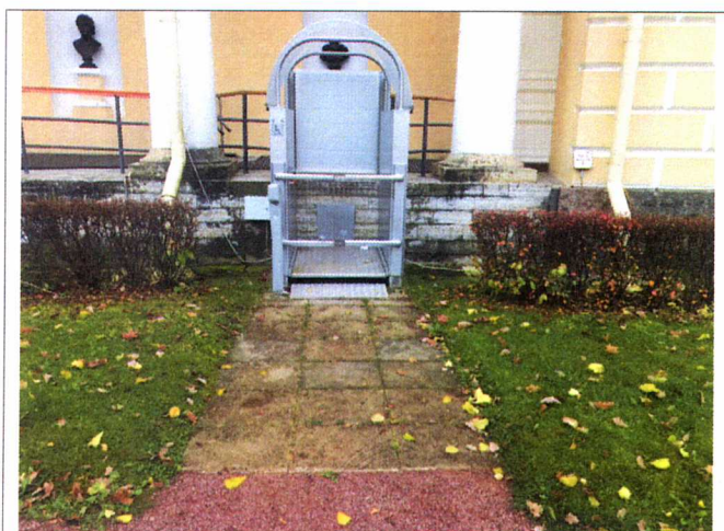
Фото №8 –Вертикальный подъемник. Дублирует наружную лестницу главного входа
